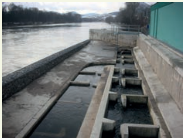
Fotografía 10 — Drenaje artificial adaptado para peces empleado principalmente para las especies más rápidas
