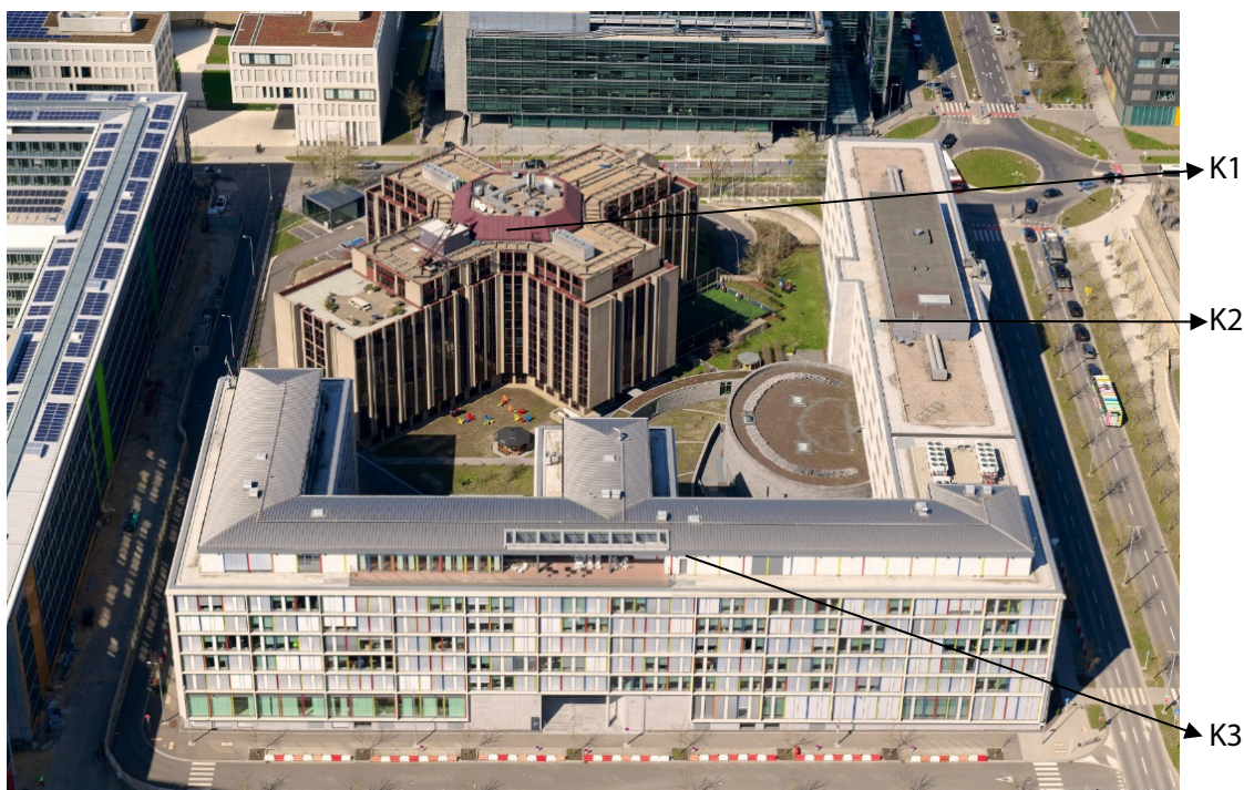
Les bâtiments de la Cour sur le plateau du Kirchberg à Luxembourg.
