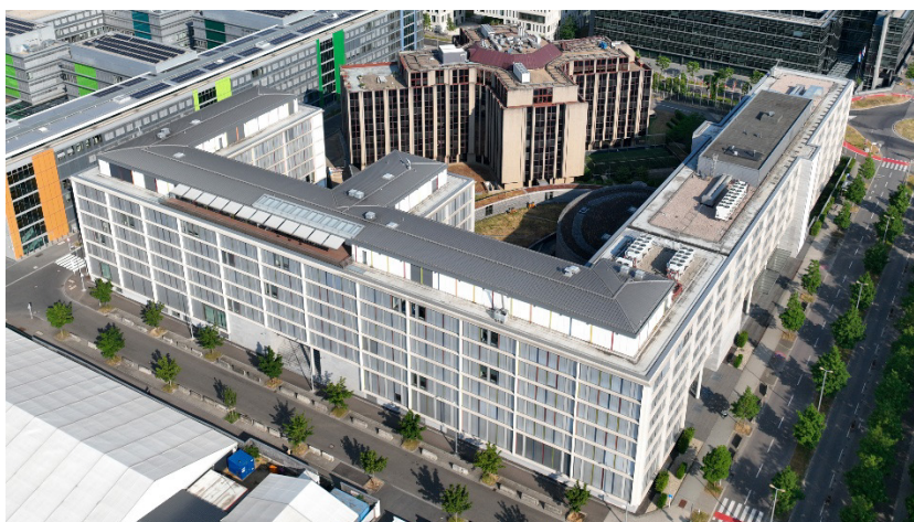
Pohled na sídlo EÚD z výšky
