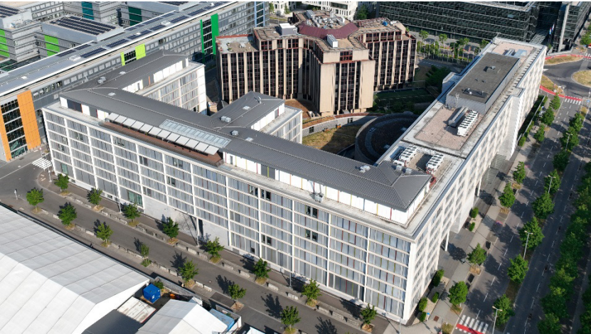
Vista aerea degli edifici della Corte
