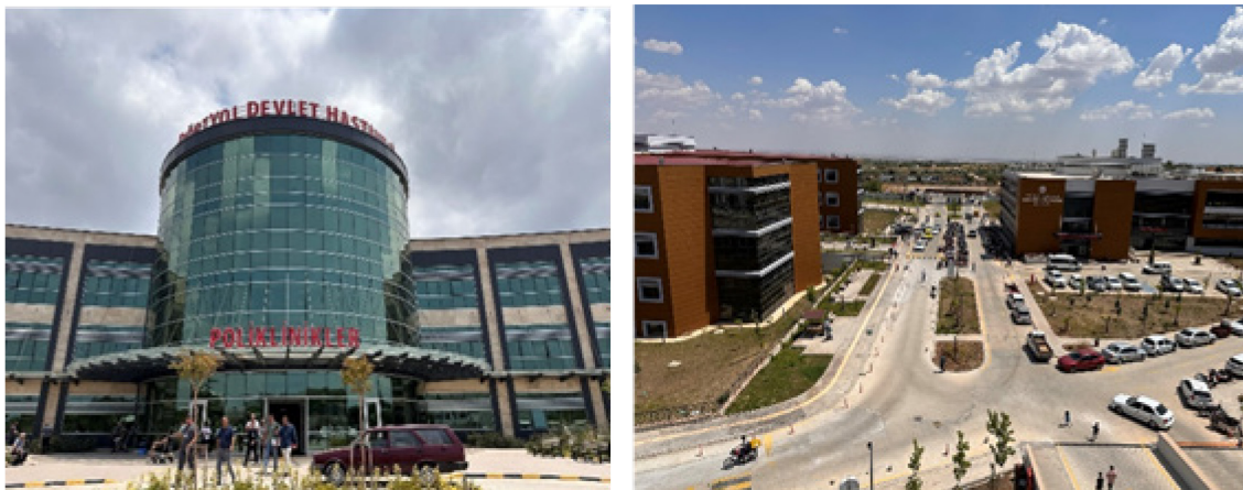
Foto 4 – Krankenhaus in Hatay (links) und Krankenhaus in Kilis (rechts)
