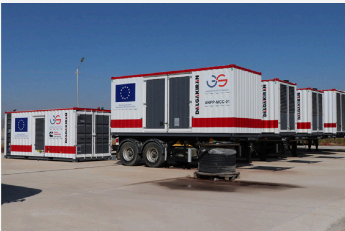
Photo 2 – Équipements financés par l'UE – Générateurs diesel mobiles de secours pour la centrale nucléaire arménienne
