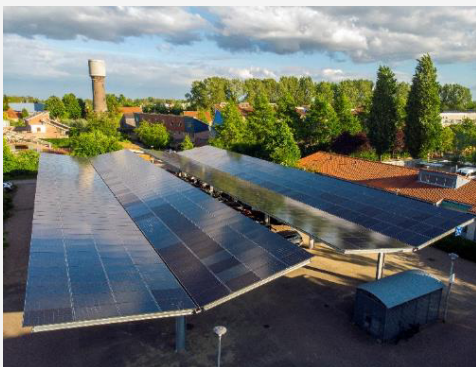
Ηλιακό υπόστεγο που παράγει ηλεκτρική ενέργεια από ανανεώσιμες πηγές και φορτίζει ηλεκτρικά αυτοκίνητα (© Amar Sjaauw En Wa)
