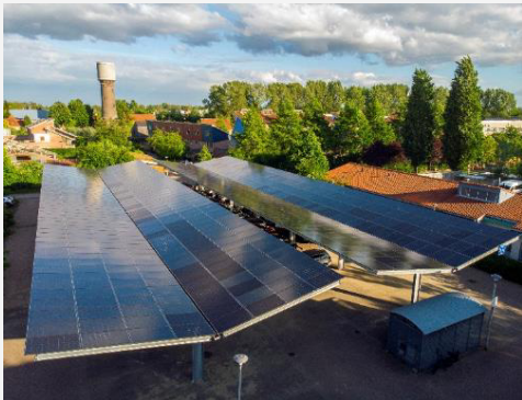
Saules enerģijas auto stāvvietā, kas ražo atjaunīgo elektrību un uzlādē elektriskos automobiļus (© Amar Sjauw En Wa)
