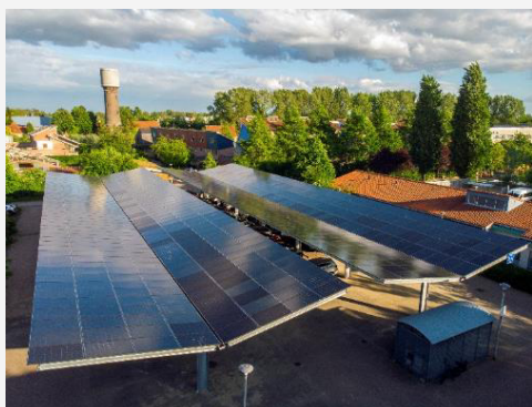
Parkirišče s solarnimi paneli, ki proizvajajo električno energijo iz obnovljivih virov in omogočajo polnjenje električnih avtomobilov (© Amar Sjaauw En Wa)
