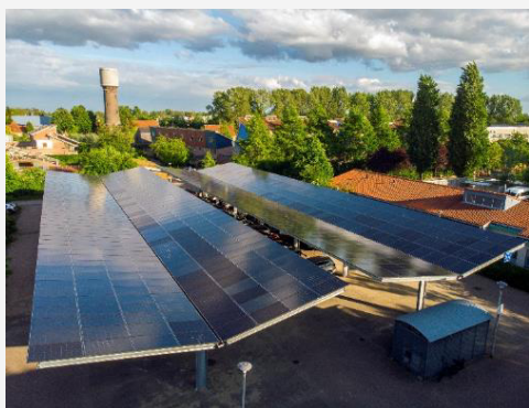
Carport med solceller som genererar förnybar el och laddar elbilar (© Amar Sjauw En Wa)
