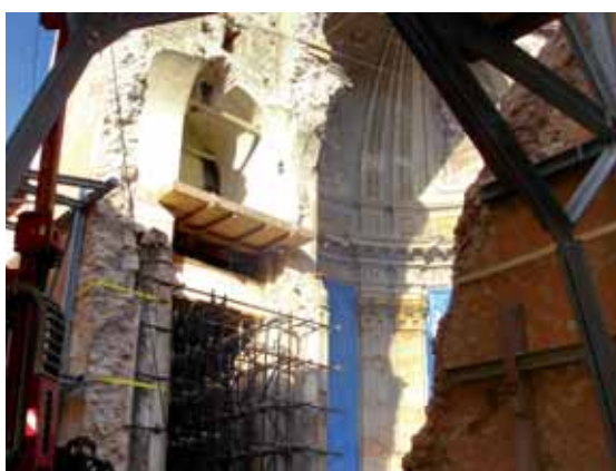
Catedral de L'Aquila, Italia, casi cuatro años después del terremoto de 2009.
