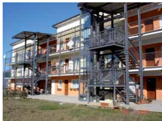
Vastarakennettu maanjäristyksen kestävä asuinrakennus L'Aquilassa, Italiassa.
