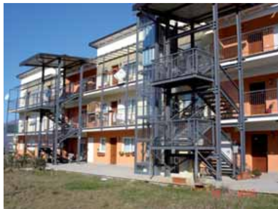
Nieuwe, seismisch geïsoleerde huisvesting in L'Aquila, Italië.
