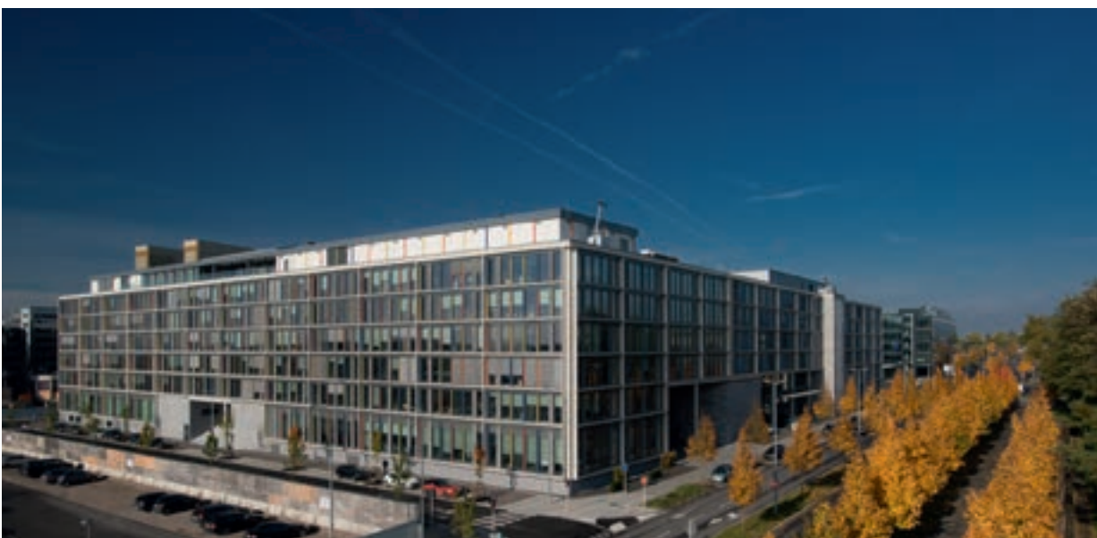
Pogled na stavbo K3, ki je del sedeža Sodišča v Luxembourggu.
