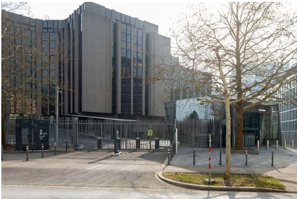
Il-binja prinċipali "K1" u ċ-ċentru l-ġdid tas-sigurtà tal-QEA f'rue Alcide De Gasperi, il-Lussemburgu.
