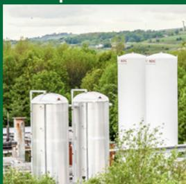
El almacenamiento de energía de aire líquido (LAES) utiliza un proceso de refrigeración para almacenar electricidad. El aire se enfría hasta que se licúa y, a continuación, el aire líquido se almacena en un tanque aislado. Para revertir el proceso y generar electricidad, el aire se expande y mueve una turbina.
