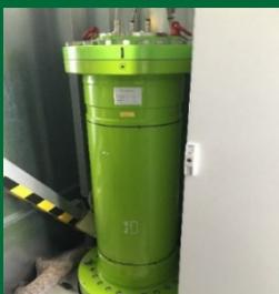
Un motor eléctrico hace girar un rotor a velocidad muy elevada, hasta 100 000 rotaciones por minuto aproximadamente. La energía se recupera al desacelerar el rotor. Las baterías inerciales son más adecuadas para el almacenamiento a corto plazo y de alta potencia, y son ideales para los servicios en la red que requieren tiempos de respuesta muy rápidos. También se utilizan en el transporte, para aportar breves impulsos de potencia.
