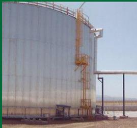
En esta forma de almacenamiento térmico se usa electricidad o energía solar para calentar un contenedor lleno de sal fundida. Este medio de almacenamiento llega a calentarse lo suficiente como para crear vapor, con lo que se pueden usar turbinas de vapor para generar electricidad a partir del calor almacenado. En combinación con la energía solar concentrada, proporciona un método para el almacenamiento diario de la electricidad solar.
