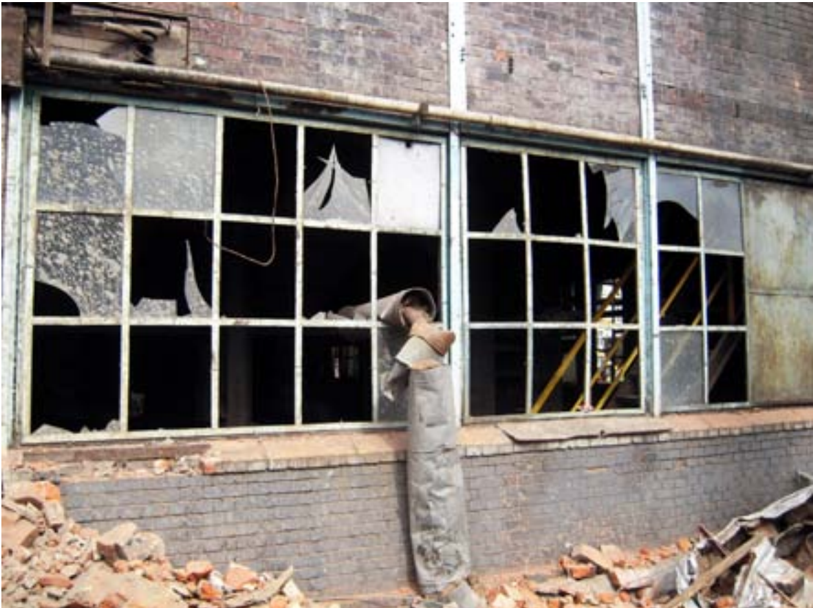
Kuva 8 – Vanhoja rakennuksia puretaan ja peruskorjataan hylätyn voimalaitoksen alueella, joka muutetaan taide- ja kulttuurikeskukseksi (Łódź, Puola)
