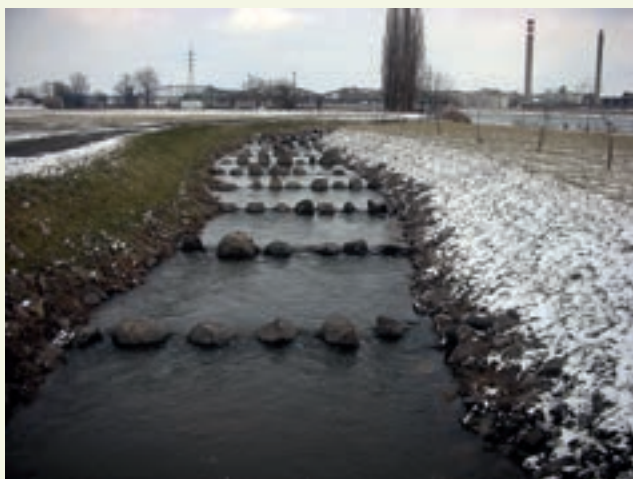
Fotografía 9 — Drenaje «casi natural» adaptado para peces empleado sobre todo para las especies más lentas
