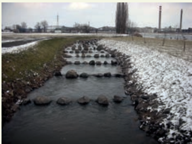
Foto 9 — Passaggio per pesci «quasi naturale» usato principalmente da specie più lente
