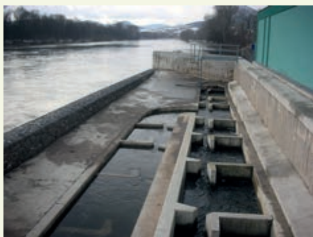
Foto 10 — Passaggio per pesci artificiale usato principalmente da specie più veloci
