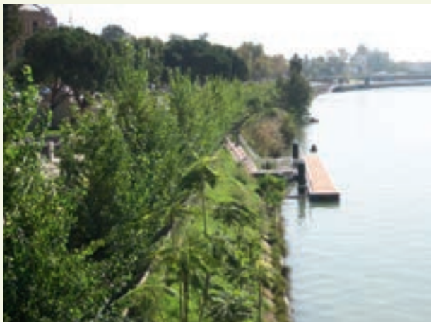
Foto 1 — Ripristino di sponde fluviali presso Siviglia
