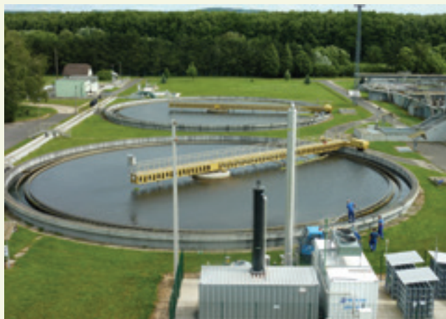
Foto 1 - Spildevandsrensningsanlæg (Ungarn - Zalaegerszeg) Kilde: Revisionsretten.
