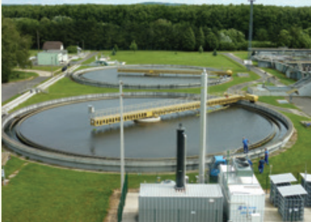
Φωτογραφία 1 — Σταθμός επεξεργασίας λυμάτων (Ουγγαρία—Zalaegerszeg) Πηγή: ΕΕΣ.
