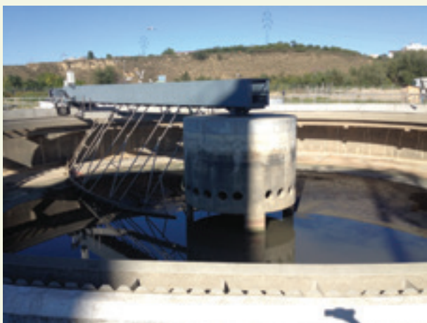
Zdjęcie 6 – Rzadko wykorzystywana część infrastruktury (Rumunia – Gałac)
