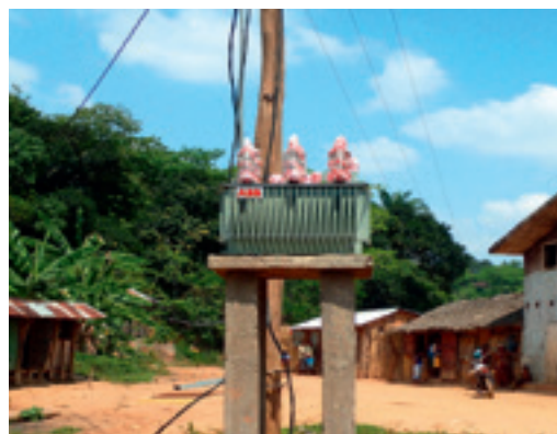
Свързване на трансформатор за ниско напрежение в разпределителната мрежа в село Сахасинака, по проекта rHYviere (провинция Фианаранцоа, Мадагаскар)
