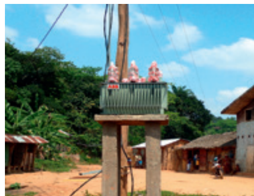
En lavspændingstransformer tilsluttes distributionsnettet i landsbyen Sahasinaka - projektet »rHYviere« (Fianarantsoaprovinsen, Madagaskar).
