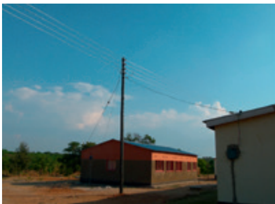
Επέκταση δικτύου, συγκεκριμένα προς την κλινική του Kamilambo, έργο «Rural electrification infrastructure and small-scale projects» (επαρχία Mumbwa, Ζάμπια)
