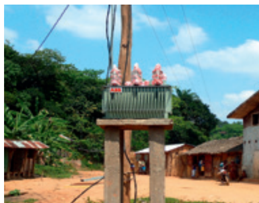
Kisfeszültségű transzformátort az elosztó hálózatra csatlakoztatnak Sahasinaka faluban, rHYviere projekt (Fianarantsoa tartomány, Madagaszkár)
