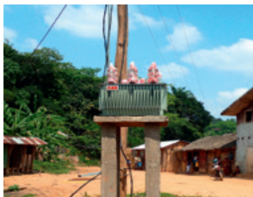
Zemsprieguma transformatora pievienošana Sahasinaka ciema sadales tīklam, rHYviere projekts (Fianaranco province, Madagaskara)
