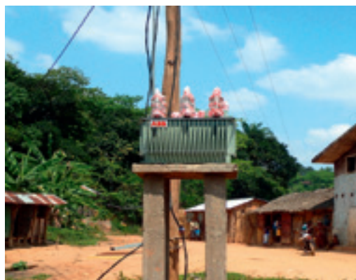
Een transformator van laag voltage wordt aangesloten op het distributienet in het dorp Sahasinaka, in het kader van het rHYviere-project (Provincie Fianarantsoa, Madagaskar)
