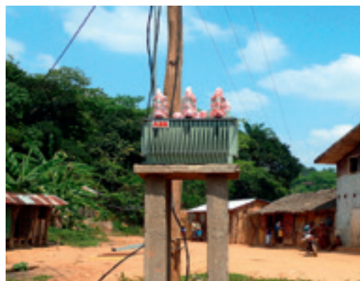
Podłączenie transformatora niskiego napięcia do sieci dystrybucyjnej w wiosce Sahasinaka, projekt rHYviere (prowincja Fianarantsoa, Madagaskar)
