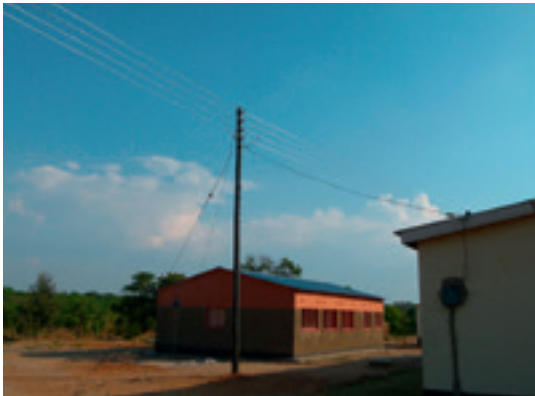
Širitev omrežja, zlasti za kliniko Kamilambo, infrastruktura za elektrifikacijo podeželja in majhni projekti (okrožje Mumbwa, Zambija)
