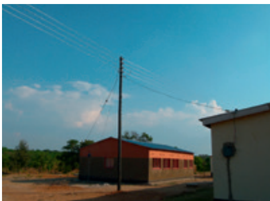
Utbyggnad av elnätet, bl.a. till Kamilambo-kliniken, Rural electrification infrastructure and small-scale projects (infrastruktur för elektrifiering av landsbygden och småskaliga projekt) (Mumbwa-distriktet, Zambia).
