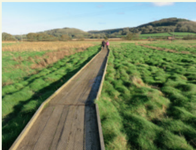
Passerella su zona umida nel Devon orientale (Regno Unito)
