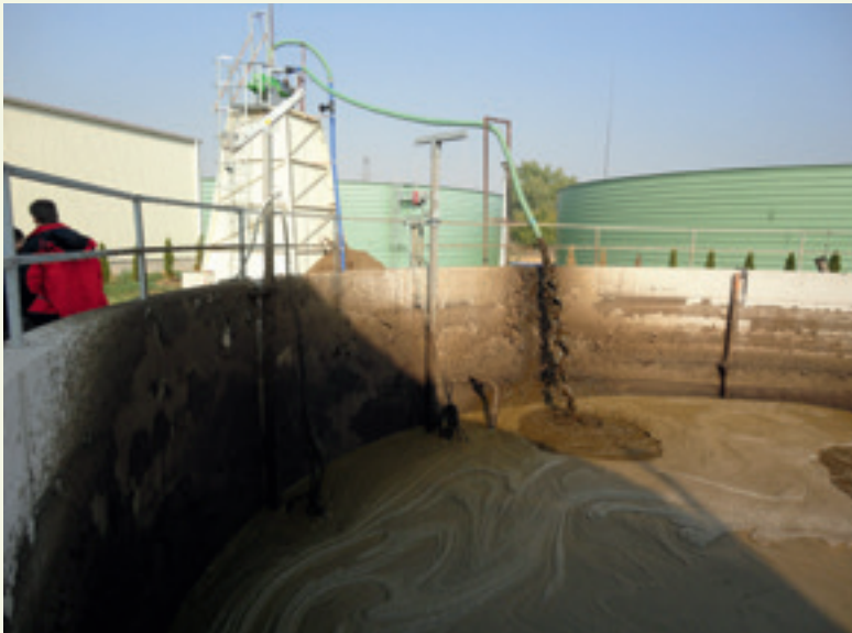
Fotografía 2. Depósito de almacenamiento de purines
