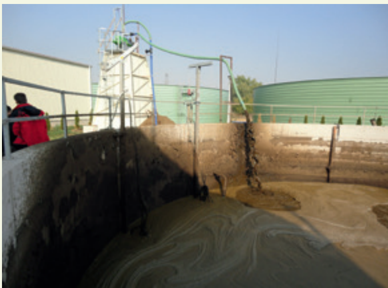
Foto 2 – Utrymme för lagring av flytgödsel.
