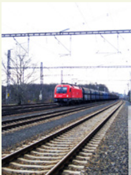
Photo 2 – Train de marchandises traversant la jonction ferroviaire reconstruite de Břeclav (République tchèque)
