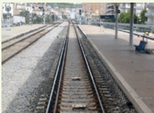
Photo 1 – Gare de marchandises de Gérone – Projet de contournement de Figueras (Espagne)
