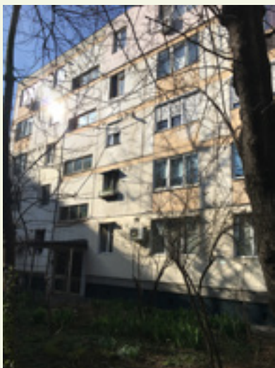
Bytový dům ve stavu před realizací investice (v blízkosti místa projektu)
