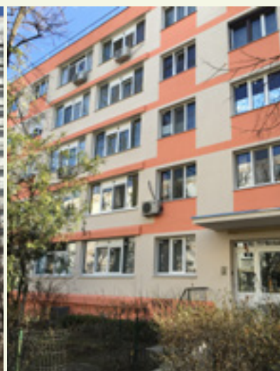
Stambena zgrada nakon ulaganja (lokacija za provedbu projekta)
