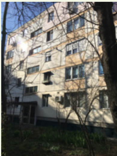
Stanovanjski blok pred naložbo (poleg kraja projekta)
