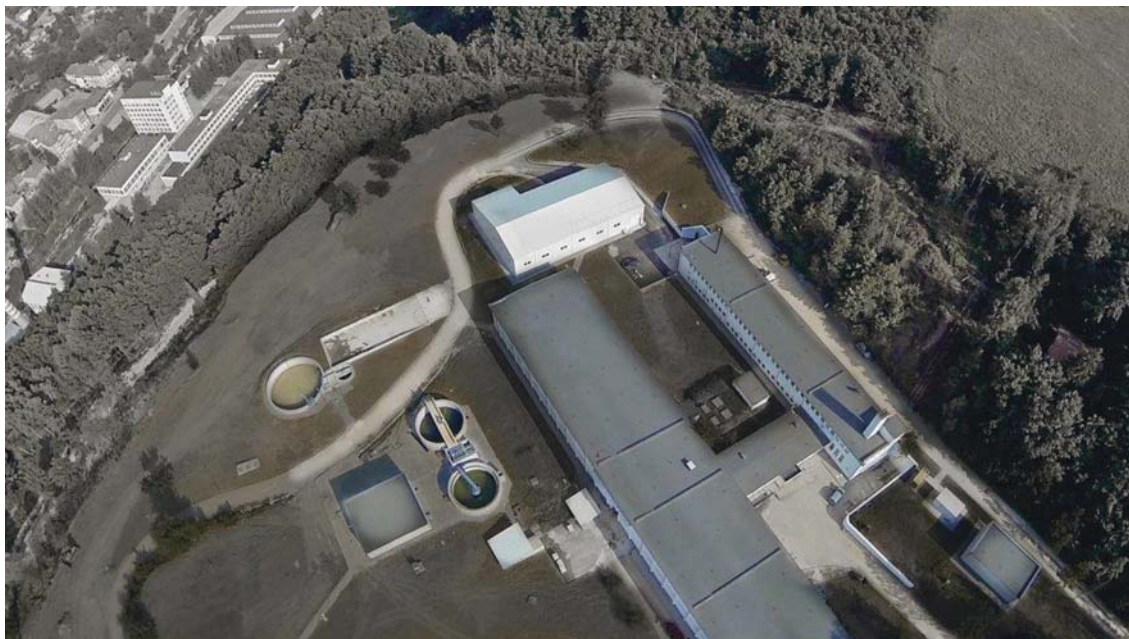
Bild 4 – Vattenberedningsanläggningen i Gabrovo (Bulgarien)
