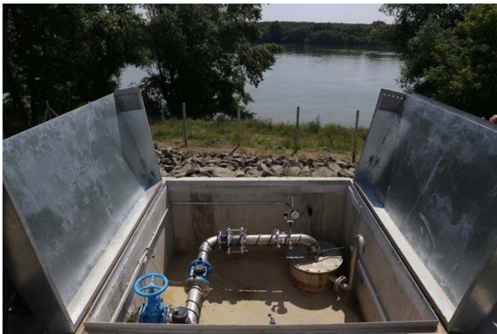
Bild 5 – Brunn som tillhandahåller strandfiltrerat vatten från Donau, Ungern
