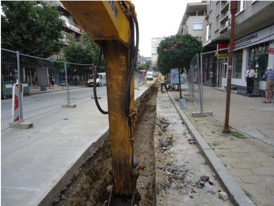
Bild 3 – Utgrävningsarbeten i Veliko Tarnovo (Bulgarien)
