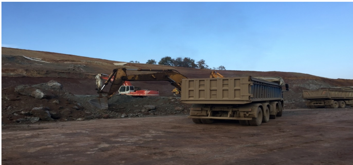
Figur 7 – Byggarbete på den centrala motorvägen E-65 i Grekland
