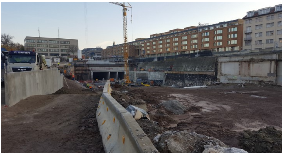
Снимка 2 – Строителни работи на гара „Щутгарт 21“
