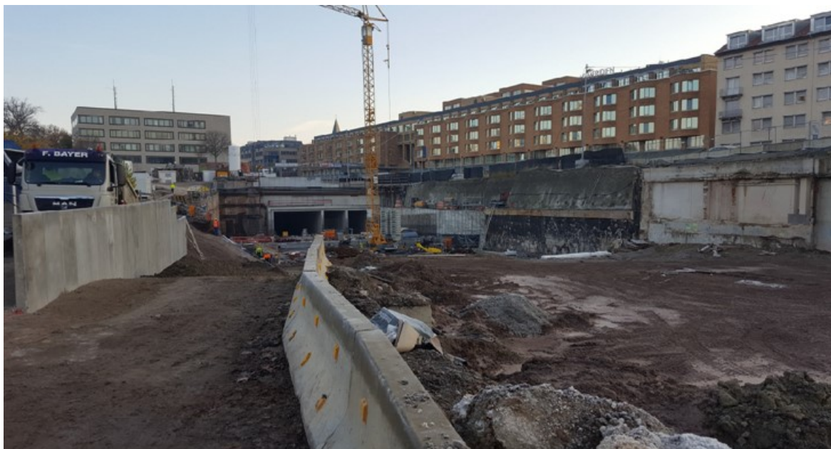
Obrázek 2 – Stavební práce u projektu stanice Stuttgart 21
