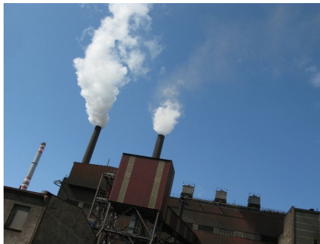
Finanzierte Industrieanlage in Ostrava Quelle: Europäischer Rechnungshof.
