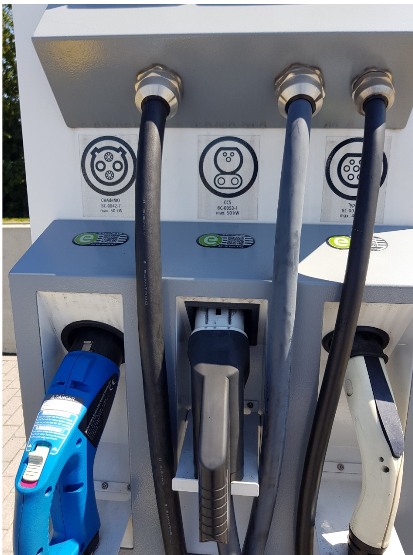
Slika 2 – Polnilnik, ki podpira več standardov (CHAdeMO, CCS, tip 2) in ki se je financiral iz IPE
