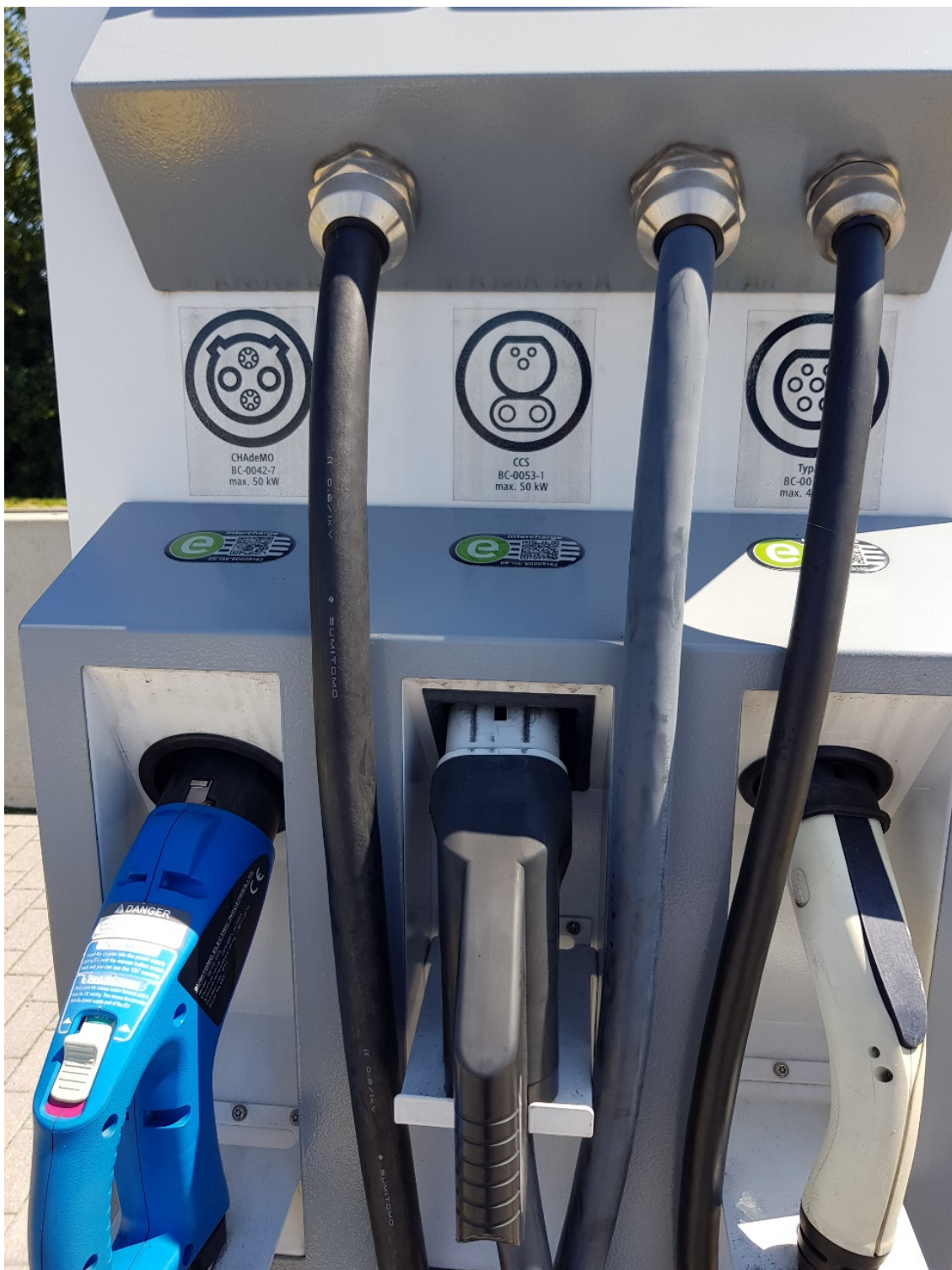
Bild 2 – Laddare för flera olika standarder (CHAdemo, CCS, typ 2) som finansieras av FSE
