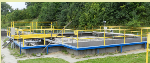
Construcción de una red de suministro de agua y alcantarillado en Polonia (Medida 321, beneficiario público)
