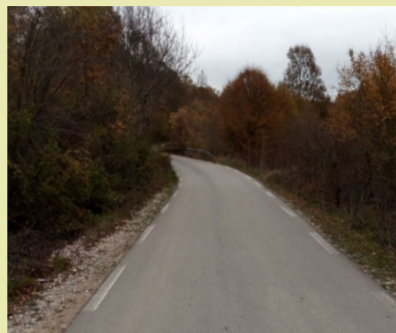
Strada rurale in Bulgaria (misura 321, beneficiario pubblico) Costi ammissibili: 1 210 052 euro Finanziamento pubblico: 100 %
