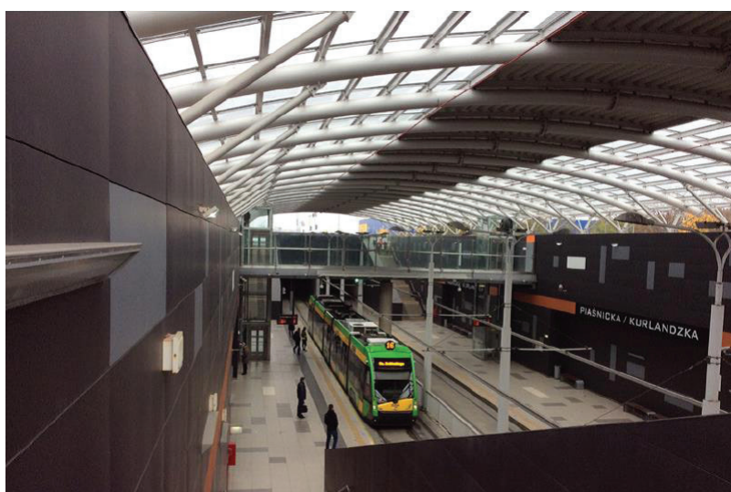
Budowa trasy tramwajowej Os. Lecha-Franowo
