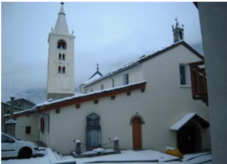
Fotografie 10 – Projekt renovace vnějších zdí a střechy kostela (Francie)
