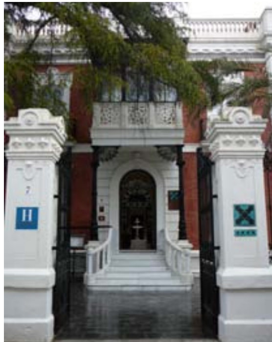
Φωτογραφία 1 — Χαρακτηρισμένο διατηρητέο κτίριο που μετατράπηκε σε ξενοδοχείο τεσσάρων αστέρων (Ισπανία)
